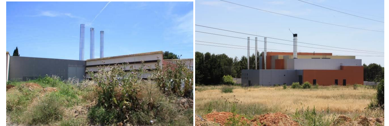
Les deux centrales thermo-frigorifiques
