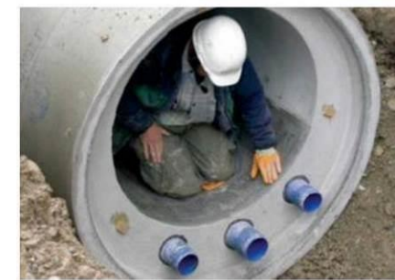
Figure 19 : Canalisation préfabriquée avec échangeur de chaleur intégré (Source : Guide pour les maîtres d'ouvrages et les communes, OFEN)
