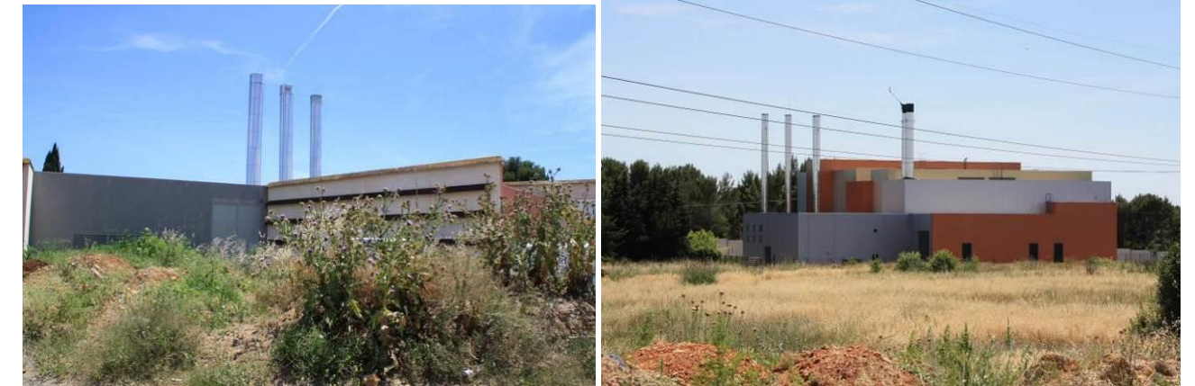
Les deux centrales thermo-frigorifiques
